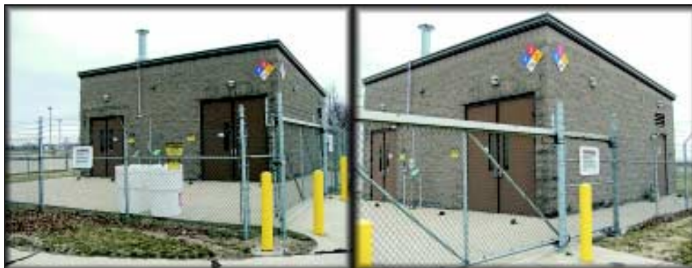
Fot. 2. Typowy budynek magazynu hydrazyny z systemami zabezpieczenia i ostrzegania
