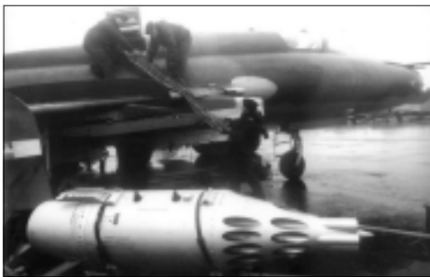
Ładowanie taśmy amunicyjnej do działka NR-30. Obok samolotu zasobnik-wyrzutnia niekierowanych pocisków rakietowych UB-16-57. Fot. Leszek Wróblewski, WAF
