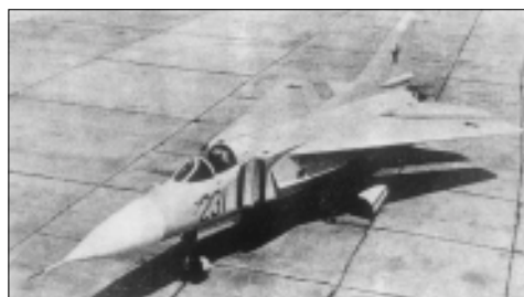
Pierwszy prototyp samolotu MiG-23 o zmiennej geometrii skrzydeł (skrzydła w pozycji 72°).
